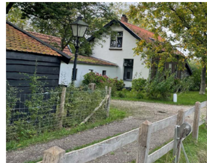
Foto sluiswachterswoning bij Werkhoven
