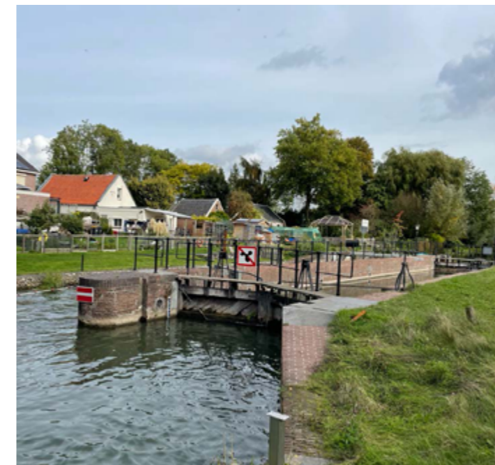
⑦ Foto schutsluis bij Cothen
