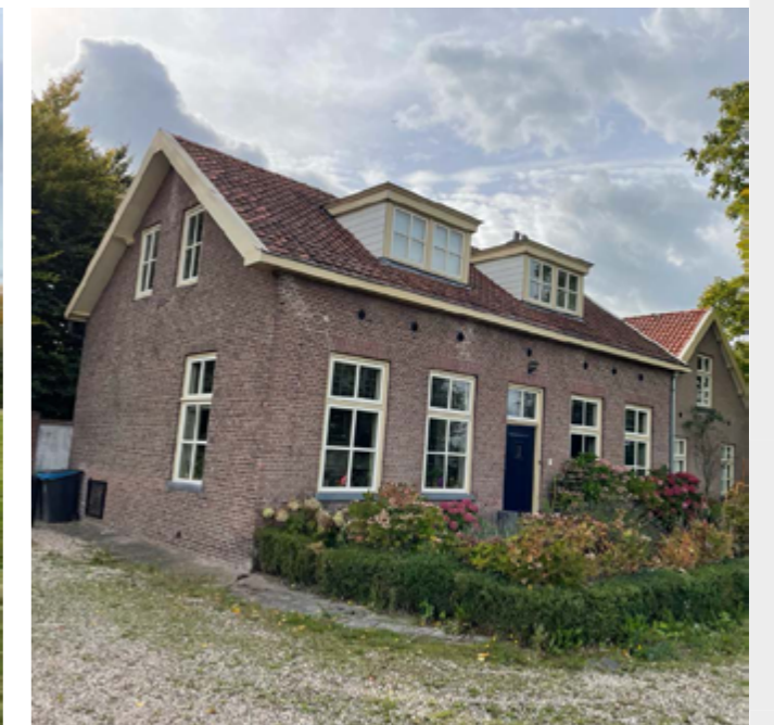
⑧ Foto sluiswachterswoning bij Cothen
