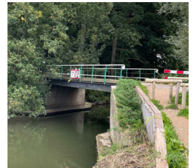
Foto Beverweerdsebrug of 'Ijzeren brug'
