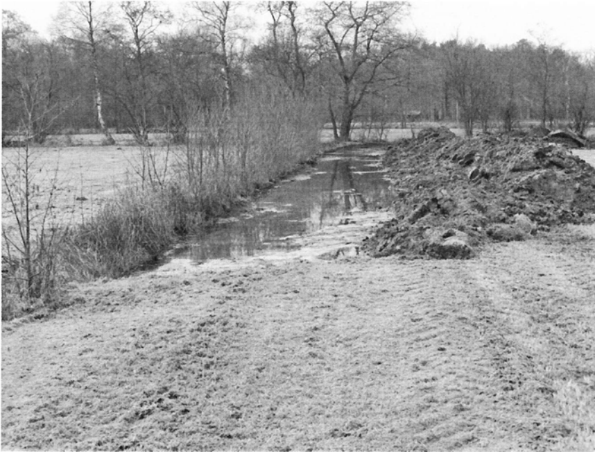
Start inrichtingswerkzaamheden in 2009
