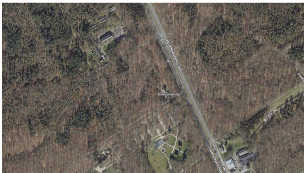
Figuur 2-2: Luchtfoto (2021) van Alexanderkwartier en omgeving (bron: StreetSmart Cyclomedia)
