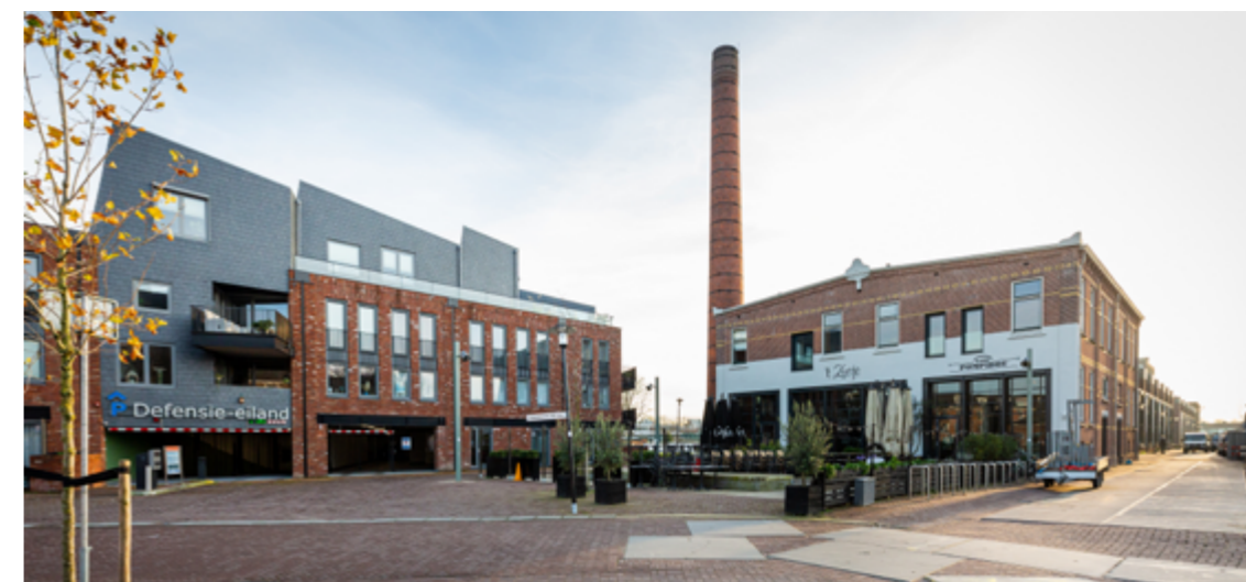
Restaurant in voormalige wasserij
