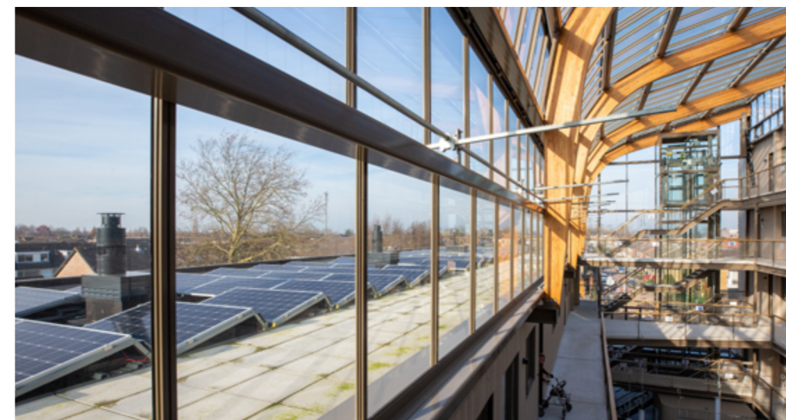
Zonnepanelen en overkapping
