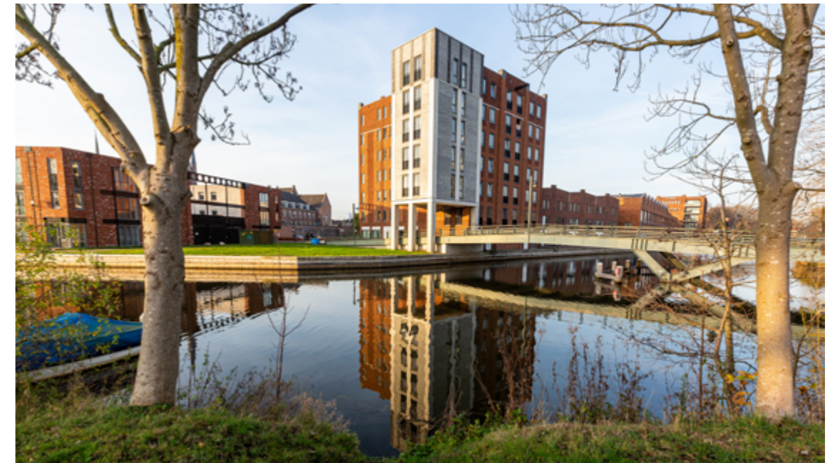
Appartementen aan het water
