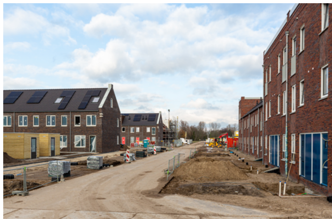
Woningen in aanbouw
