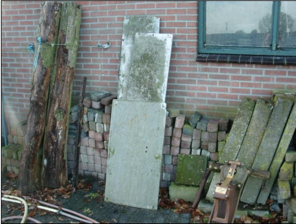
Foto 9, Naast en achter varkensstal; AC plaatmateriaal losstaand (op 4 locaties) Monster als AMP002
