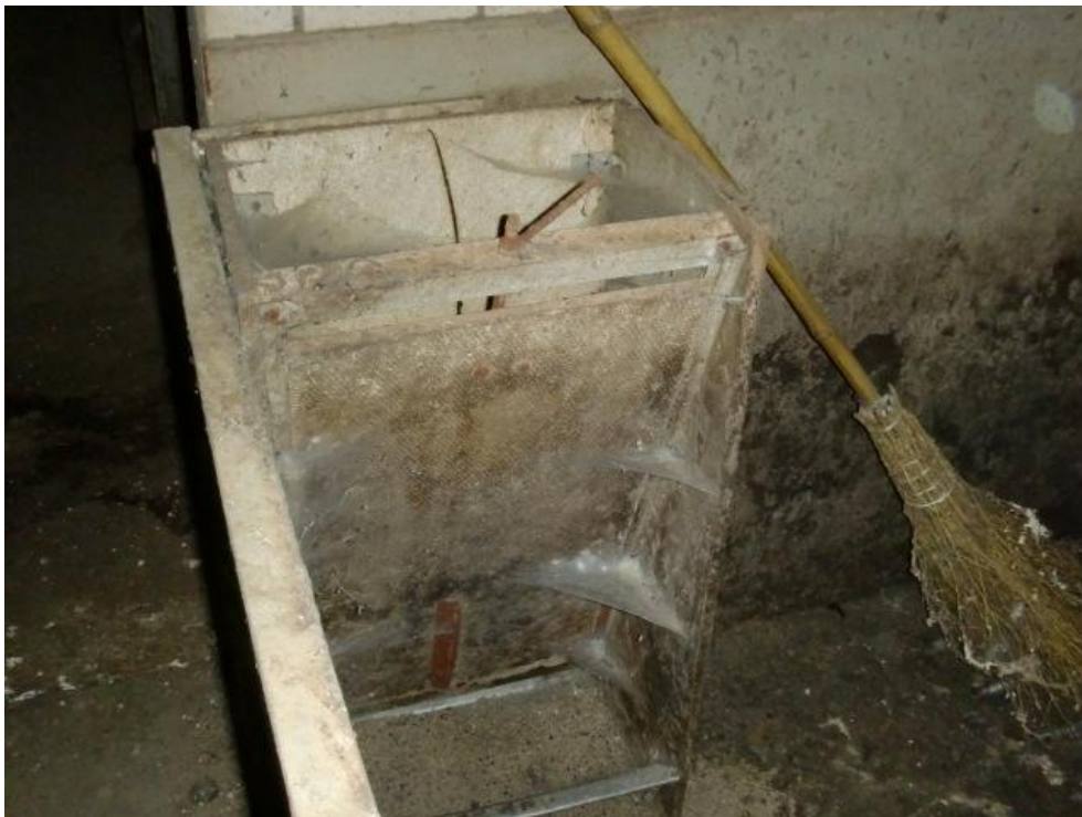
Foto 8, Varkensstal, voederbakken; AC plaatmateriaal Monster als AMP002
