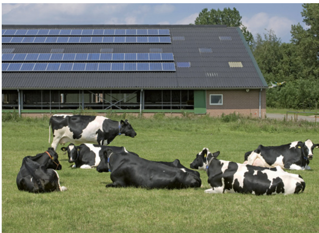
Opwekking zonne-energie op dak van stal
