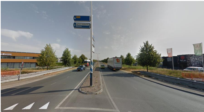
Figuur 2-2 Rondweg-Oost gezien vanaf rotonde bij de Smalle Zijde in noordelijke richting. Tot de rotonde bij de Wageningselaan is het een 2x2-strooks weg (bron: Google Streetview)
