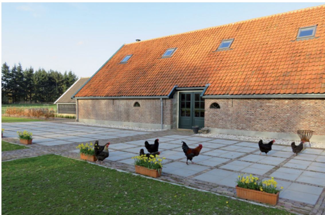
Stal Vollenhoven - Na renovatie
