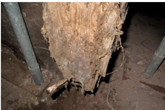
Stal Vollenhoven - Voor renovatie
