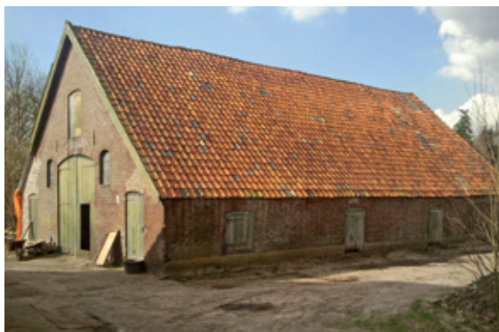
Stal Vollenhoven - Voor renovatie
