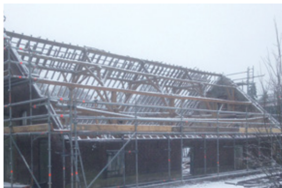
Stal Vollenhoven - Tijdens renovatie
