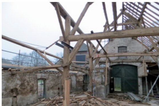
Stal Vollenhoven - Tijdens renovatie
