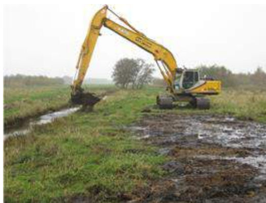
Figuur 5.3 Baggeren van watergangen in OVP Weersloot. <foto: Ecogroen, 2012 / M. Meyling>
