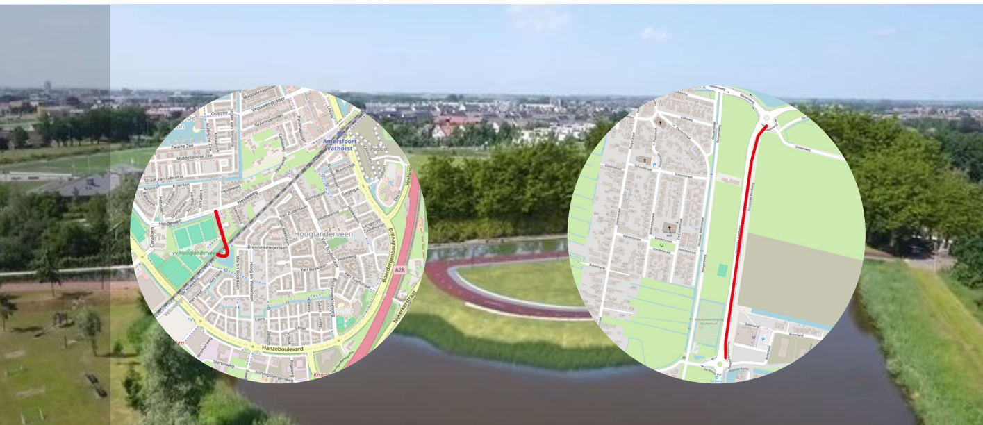
Figuur 4.2: Fietstunnel Veentunnel-Willem Tomassenlaan.
