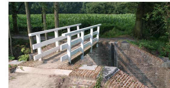
Doorlaatsluis om inundatiewater vast te houden
