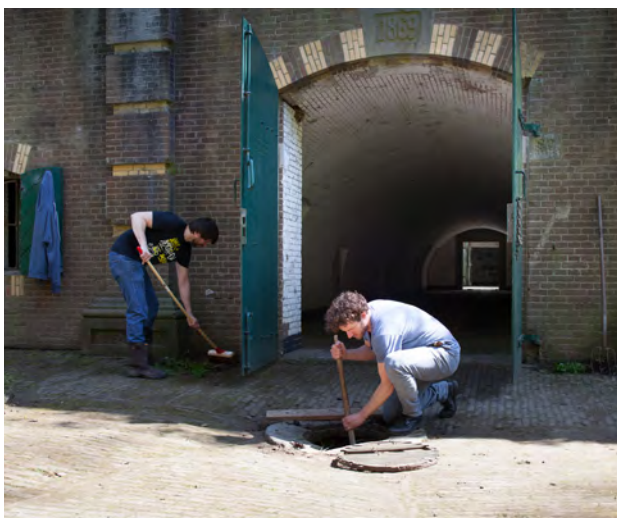
Onderhoudswerkzaamheden door vrijwilligers aan een fort.
