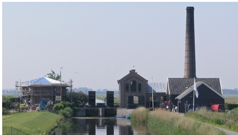
Stoomgemaal Hertog Reynout met links de onderbouw van de oude molen
