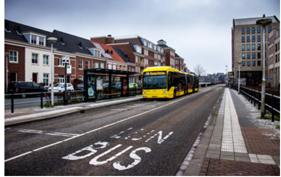
HOV-baan richting station Vleuten
