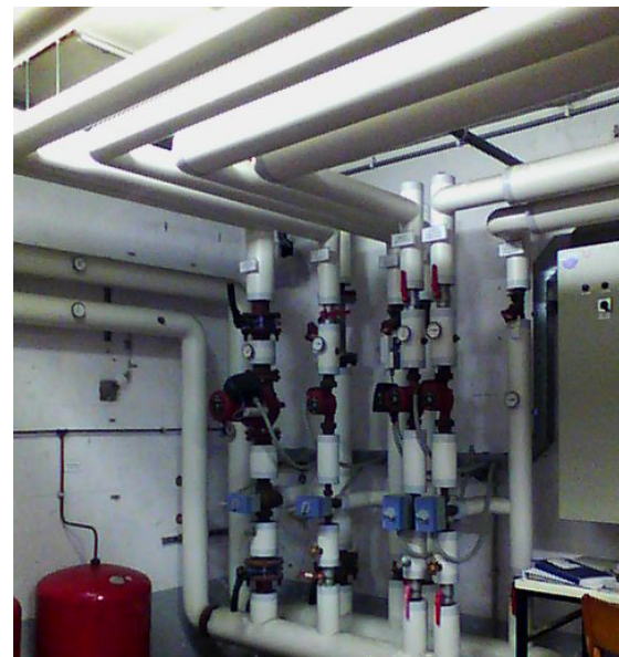
Ongeïsoleerde kranen en koppelingen bij een verdeelstation van de verwarming geven veel energieverlies.
