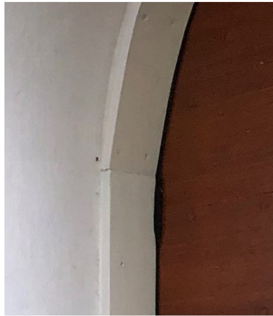
Voorbeeld van een lat met kierdichting aangebracht in de negge bij een deur die in een steensponning is geplaatst.
