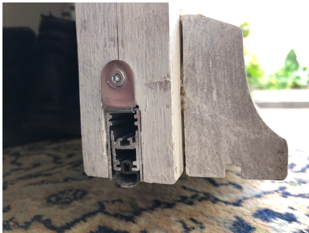
Schematische weergave van een valdorpel op de deur gemonteerd en een valdorpel die in de deur is aangebracht.
