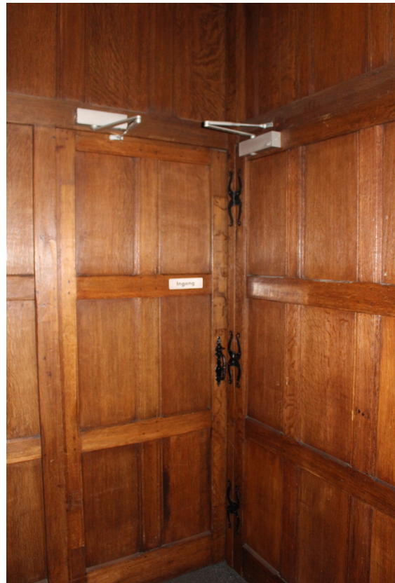
Een houten tochtportaal in de Nicolaïkerk in Utrecht. Een tochtportaal en de toepassing van deurdrangers kan veel warmteverlies voorkomen.
