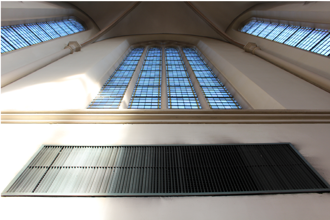
Inblaasrooster van de luchtverwarming in de Jacobikerk te Utrecht.
