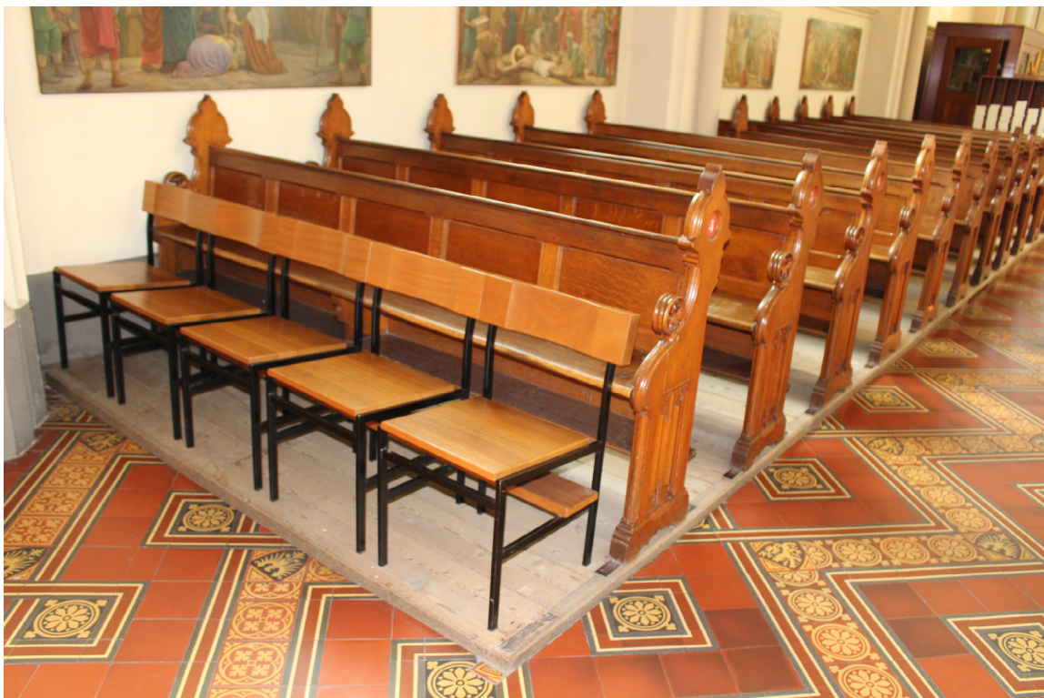
Houten vlonder onder kerkbanken in de H.H. Cosmas en Damianus te Abcoude. Onder de vlonder kan vloerverwarming worden aangebracht (met een nieuwe dunnere afwerkingslaag).
