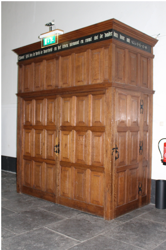
Een houten tochtportaal in de Nicolaïkerk in Utrecht. Een tochtportaal en de toepassing van deurdrangers kan veel warmteverlies voorkomen.
