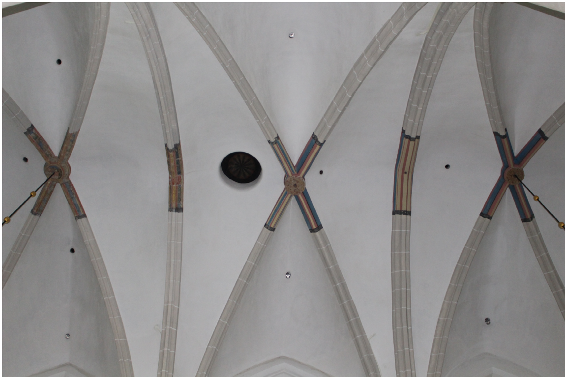
Gewelven in de Jacobikerk in Utrecht; bestaande ventilatiegaten kunnen vaak gebruikt worden voor mechanische ventilatie.
