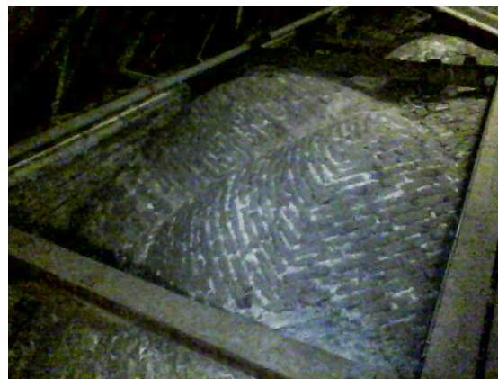
Een warmtelek ter plaatse van een sparing in de gemetselde gewelven waardoor veel warmte verloren gaat.
