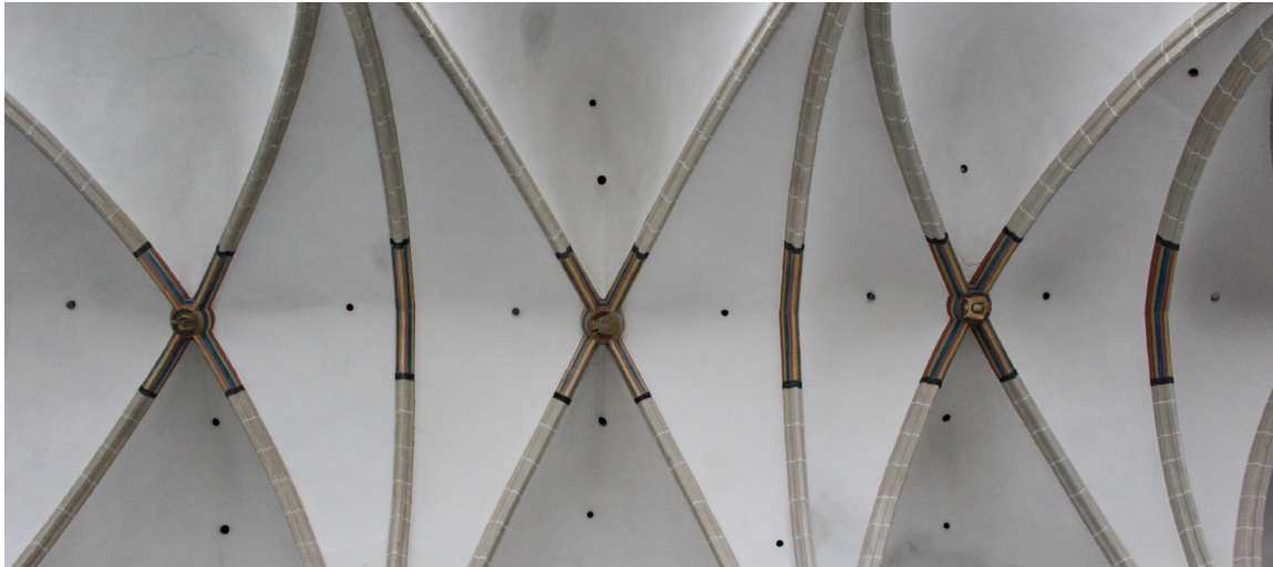
Gewelven van de Jacobikerk in Utrecht met veel gaten waardoor warmteverlies optreedt.
