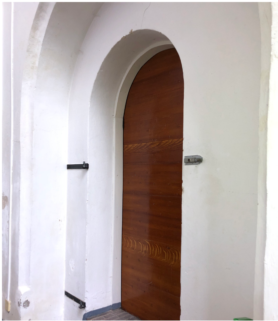
Voorbeeld van een lat met kierdichting aangebracht in de negge bij een deur die in een steensponning is geplaatst.
