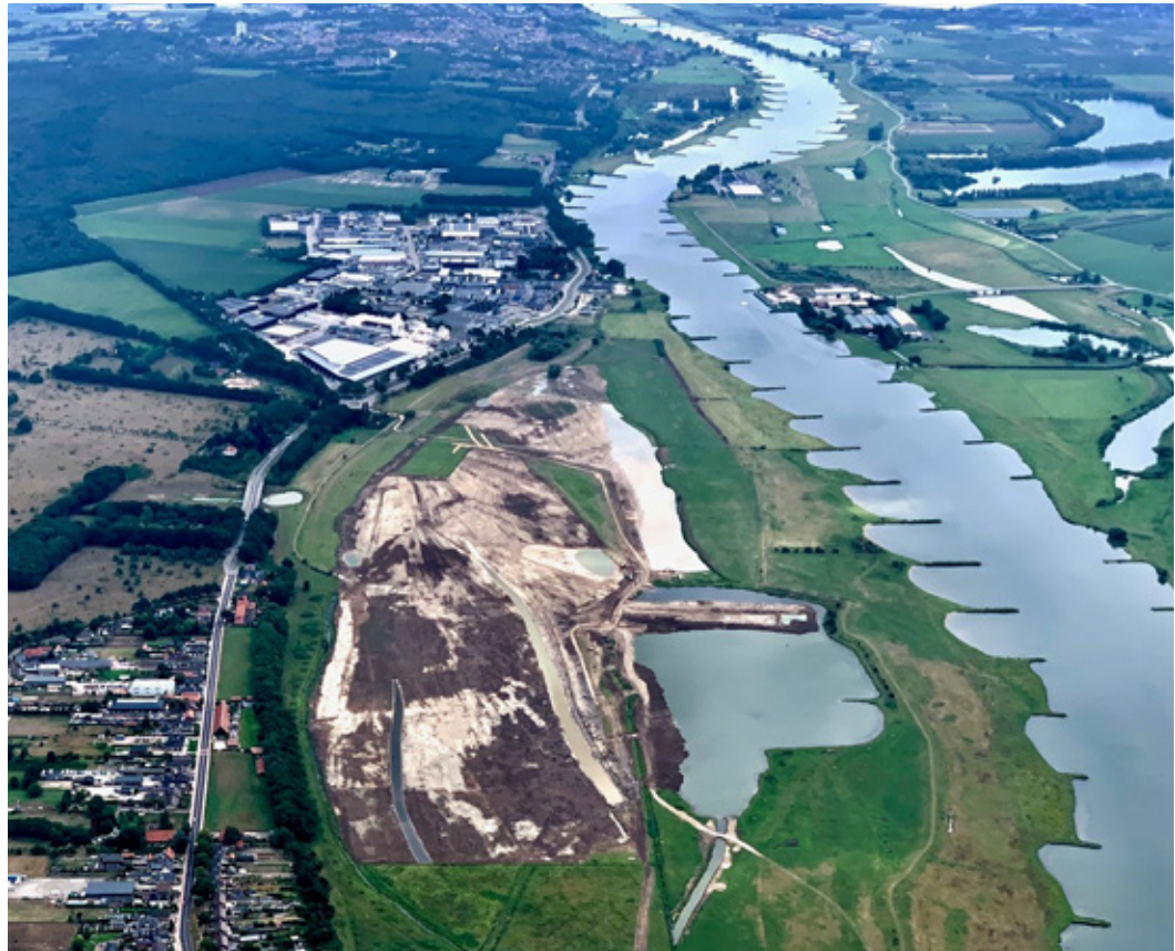
De Elster buitenwaard met werkzaamheden in uitvoering
