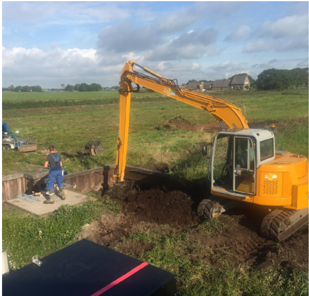
Vorbereidende werkzaamheden ten behoeve van de aanleg van moerasblok 2
