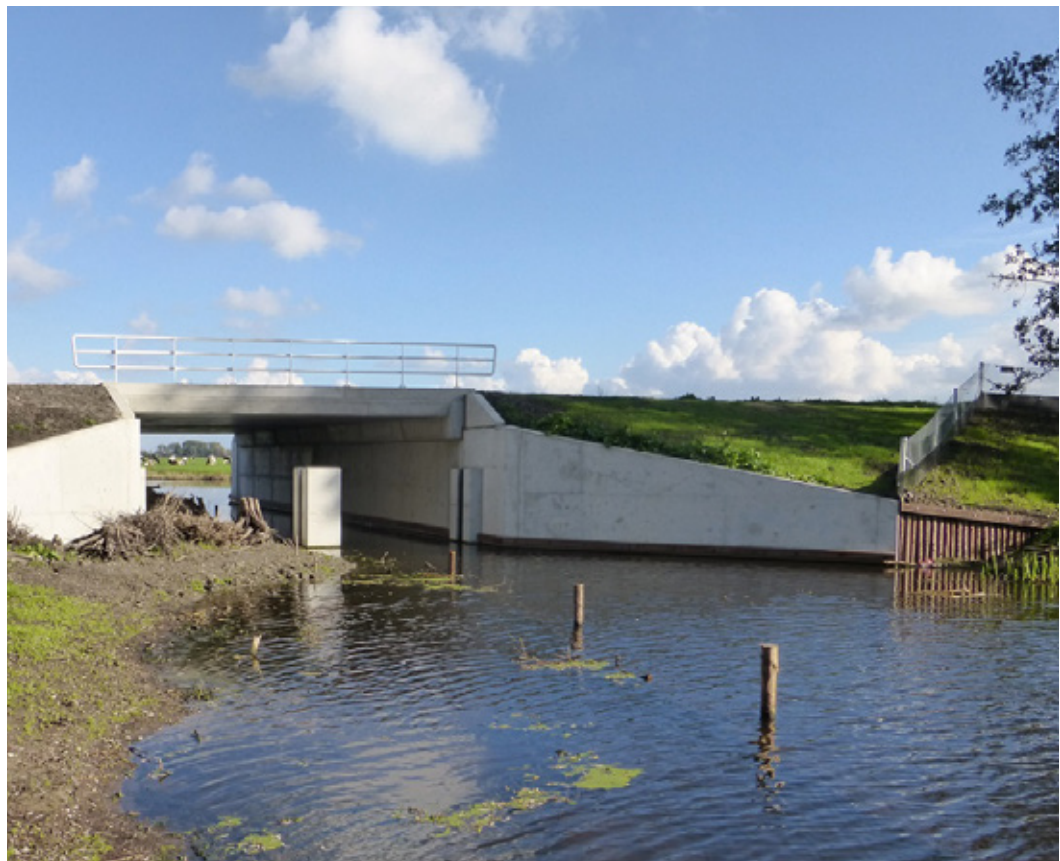
Faunapassage N212 Wilnis in aanbouw
