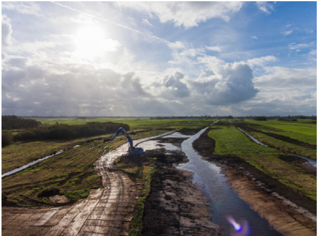
Aanleg natuurvriendelijke slootoevers in de Oostelijke Binnenpolder van Tienhoven in 2018
