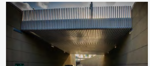
referentie houten hekwerk met doorzicht (watercampus Leeuwarden en traverse Dieren)
