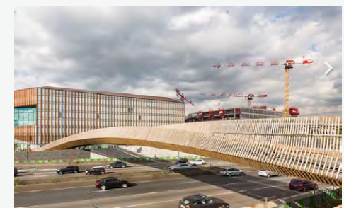
referentiebeelden materialisatie brugrand hout
